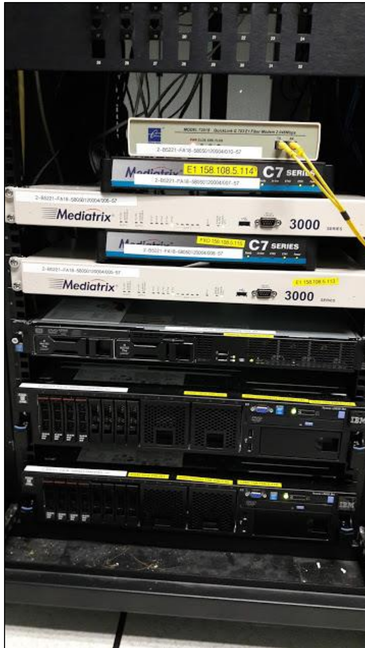
ภาพที่ 6 เครื่องคอมพิวเตอร์แม่ข่ายระบบโทรศัพท์อัตโนมัติและอุปกรณ์ส่วนควบ
